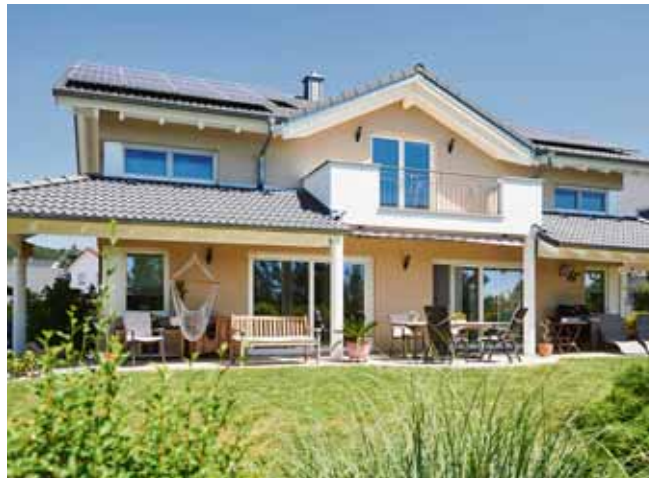
Eine gute Wärmedämmung von Dach und Fassade in Kombination mit Sonnenschutz für die Fenster, etwa mit clever geplanten Dachüberständen, erspart den Einbau einer energieintensiven Klimaanlage.
