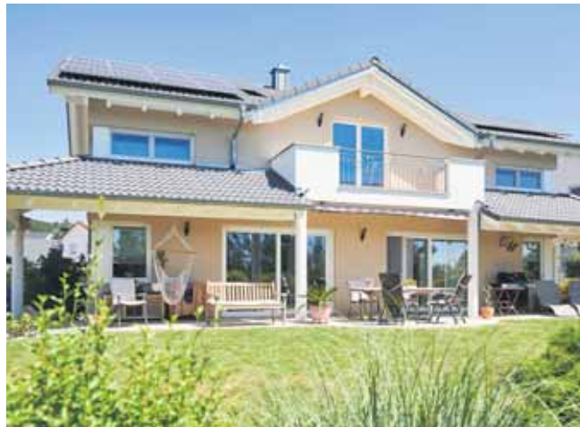
Eine gute Wärmedämmung von Dach und Fassade in Kombination mit Sonnenschutz für die Fenster, etwa mit clever geplanten Dachüberständen, erspart den Einbau einer energieintensiven Klimaanlage. Fotos: DJD/puren
